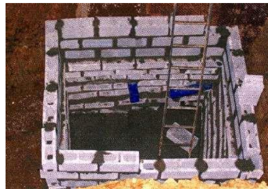
Arqueta con tubos de drenaje
